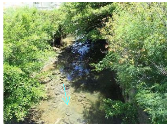
（吐口上流側の様子）
