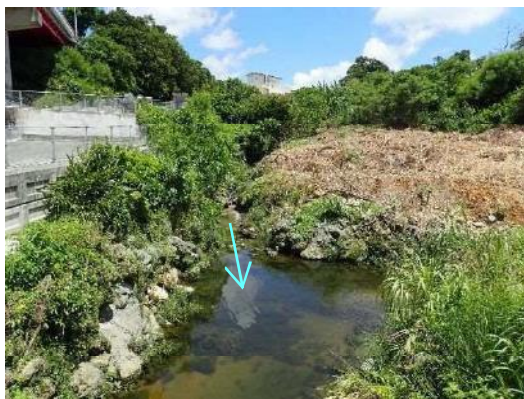
※雨水管吐口の目視確認はできず (A 地点;雨水管が合流する支川の様子)
