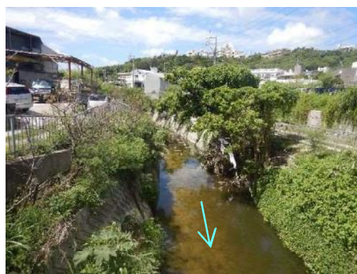
（吐口上流側の様子）
