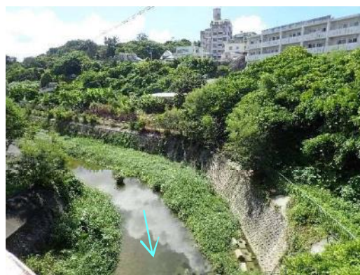
（吐口上流側の様子）
