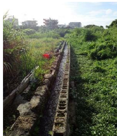
(湧水地点からの排水路)
