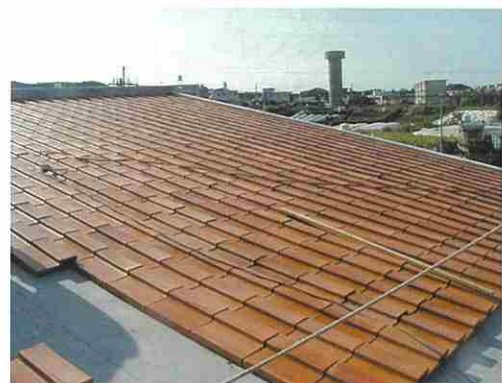
図3 機能性屋根材試作品施工実験
