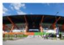
建設中のスタジアム
