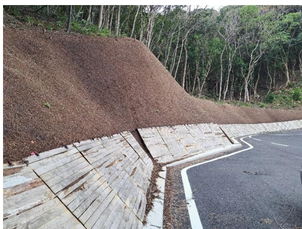
奄美産材を用いた防草パネル工
