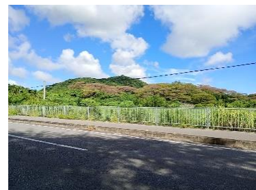
島内の被害状況
