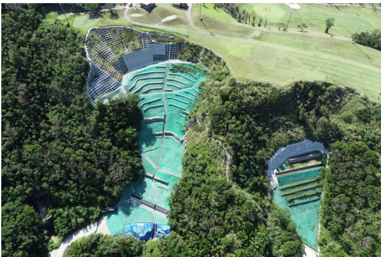
林地荒廃防止施設災害復旧事業 竣工（ 南城市 ）
