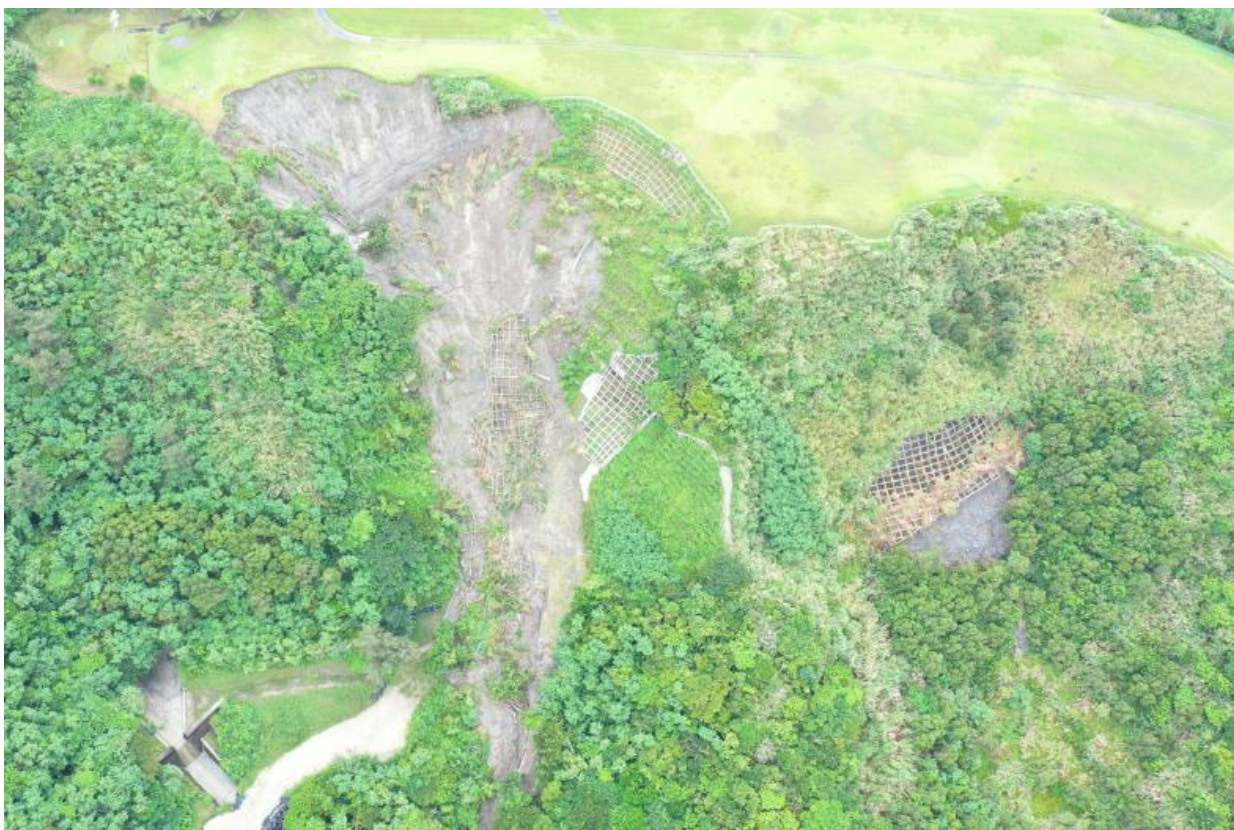
林地荒廃防止施設災害復旧事業 被災後（ 南城市 ）
