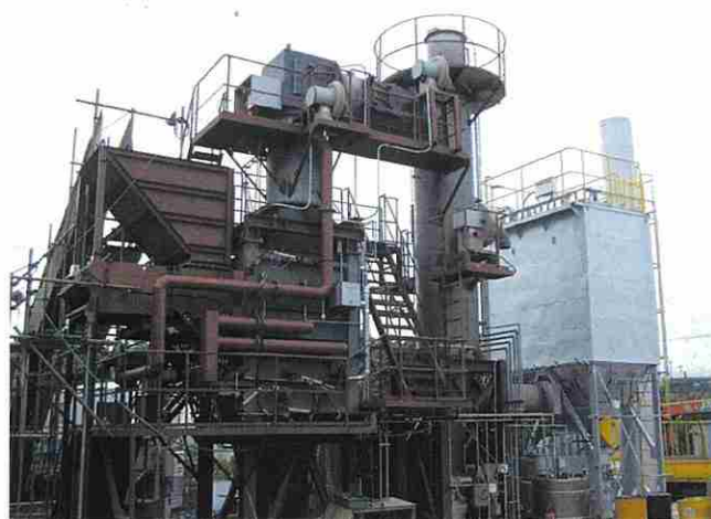
図2 完成した中型焼却炉
