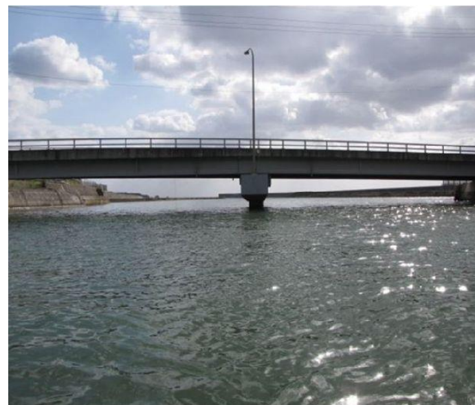
写真2 臨港道路(橋梁部)全景
