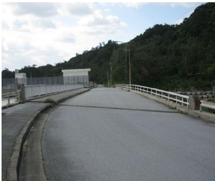
写真1 臨港道路(橋梁部)全景
