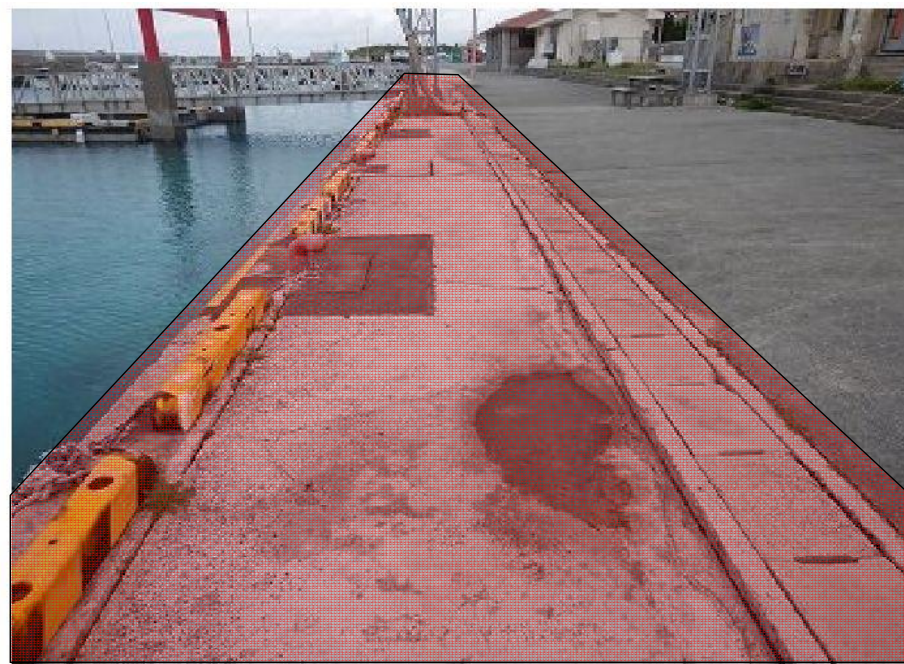
施設名：-2.5m物揚場（着手前）
