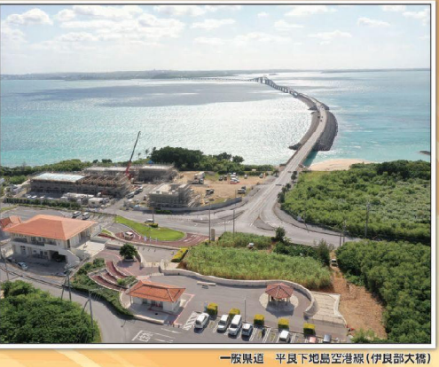
一般県道 平良下地島空港線(伊良部大橋)
