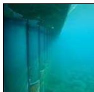
腐食部分を補修し ペトロラム被覆に よる腐食防止対策
