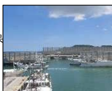
防風柵整備による 安全係留
