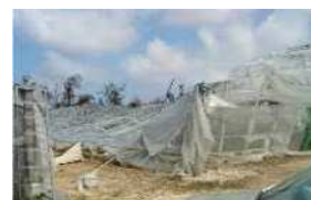
園芸施設の被害
