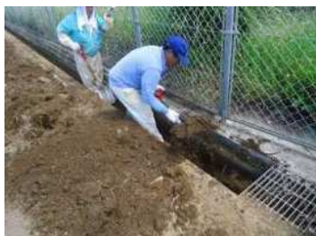
排水路の土砂上げ
