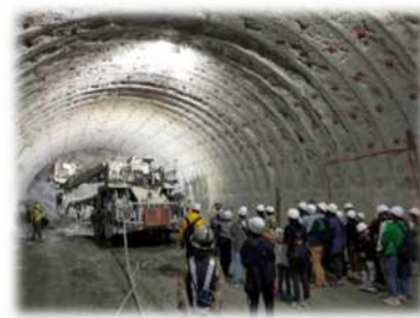
【施工中のトンネルの現場を見学】
