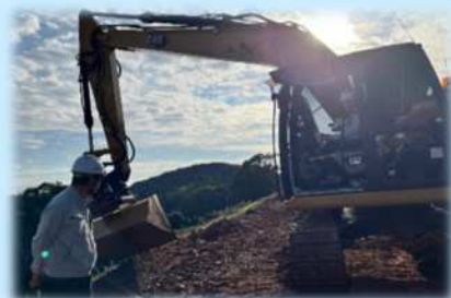
▲ICT土工(盛土)建機の体験
