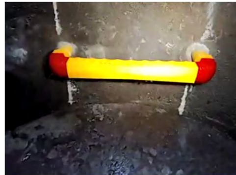
【オンライン検査（足掛金物取付確認）】
