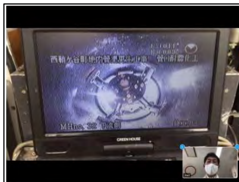
【立会状況画面（現場側）】
