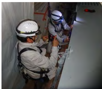
【測定箇所に照明を設置】
