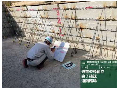
【立会状況（現場側）】
