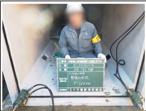
【立会状況（現場側）】
