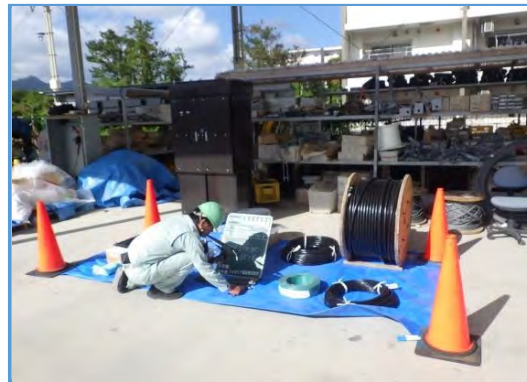
【立会状況（現場側）】
