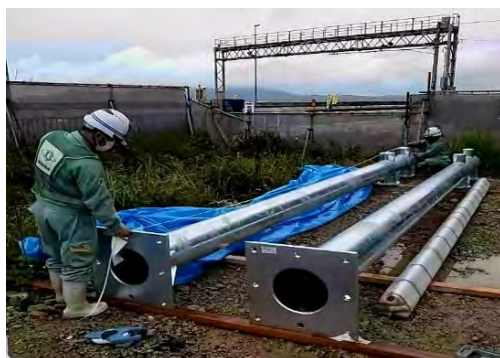
【立会状況（現場側）】
