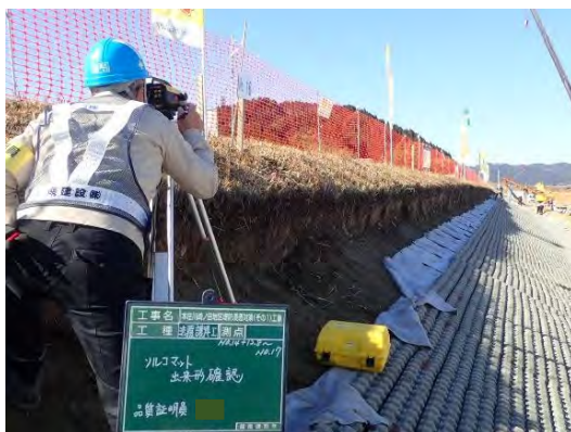
【立会状況（現場側）】
