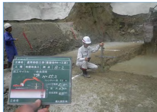
【出来形管理（杭ナビ測量）】
