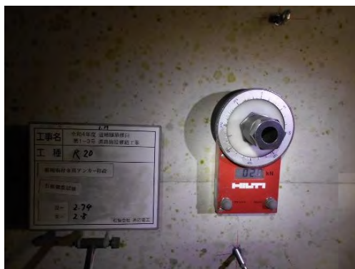
【立会状況（現場側）】
