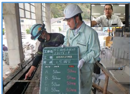
【枠内かぶり 立会状況（工場側）】
