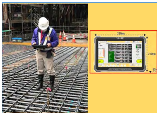
【立会状況（現場側イメージ）】
