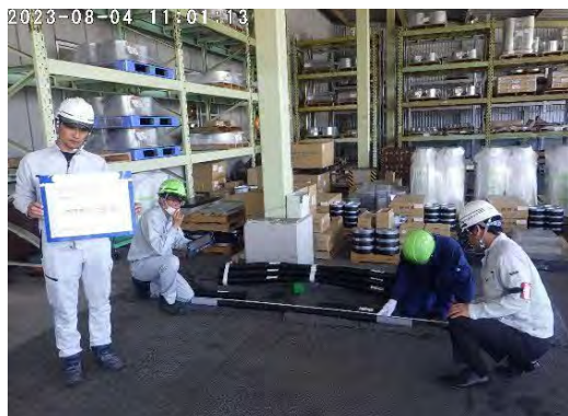
【使用材料確認（遠隔臨場）】
