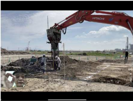
【立会状況（現場側）地盤改良工】
