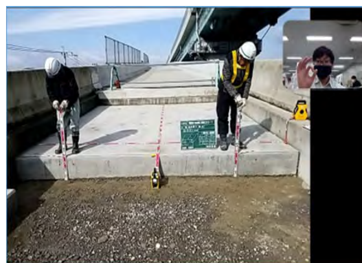
【踏掛版工の出来形検測の様子】
