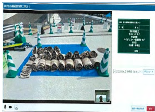
【立会状況（現場側）空袋処理】
