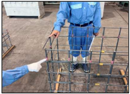
【立会状況（配筋確認）】
