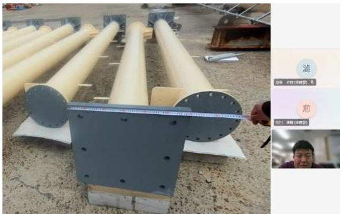
【出来形確認状況（遠景）】
