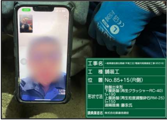
【立会状況（路盤出来形確認）】
