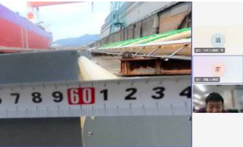
【出来形確認状況（近景）】
