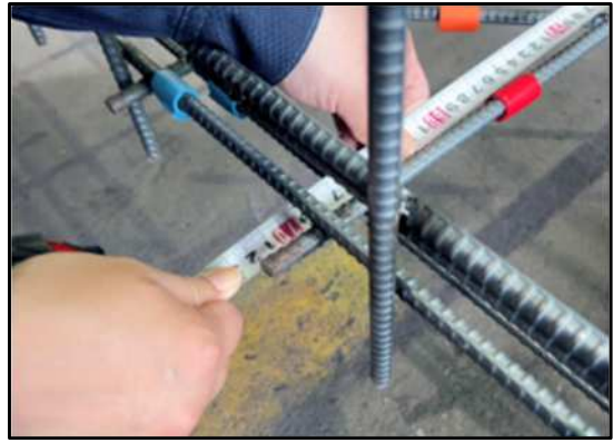
【立会状況（配筋確認；近接）】
