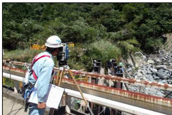
【現場確認状況（支持杭確認）】
