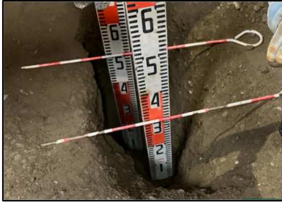
【立会状況（路盤出来形確認）】
