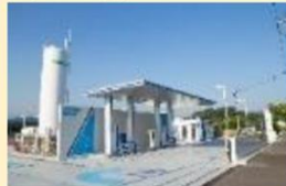
水素ステーション
