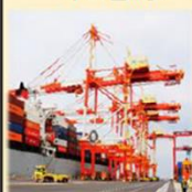
ガントリー クレーン
