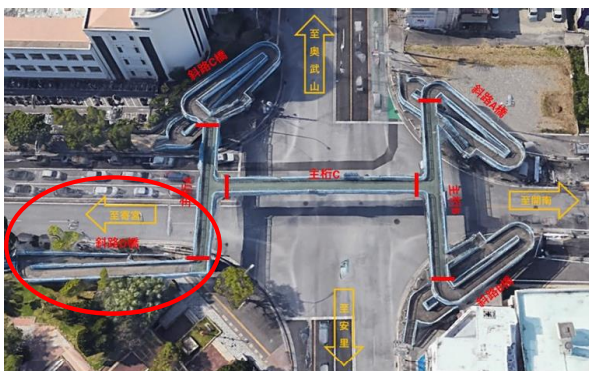
斜路D橋撤去(夜間施工)
