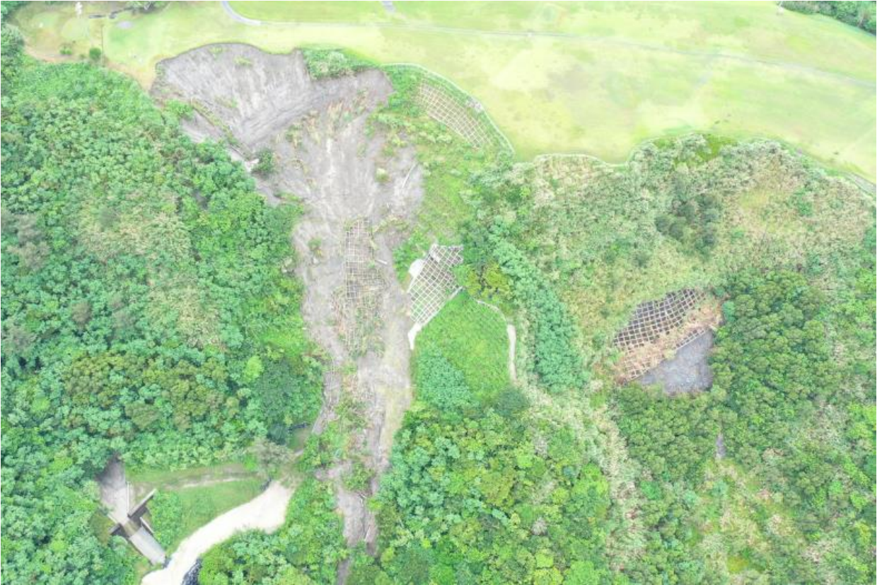
林地荒廢防止施設災害復旧事業 被災後（ 南城市 ）
