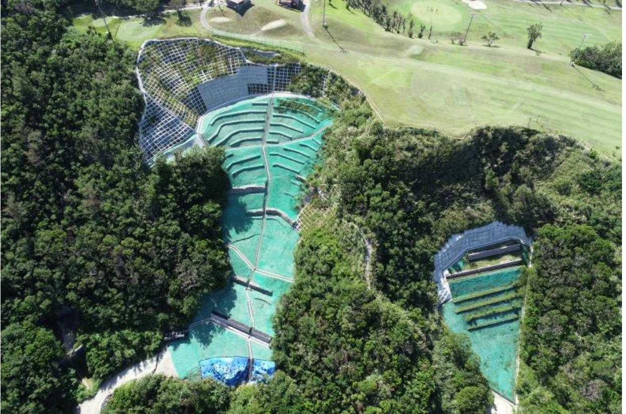
林地荒廢防止施設災害復旧事業 竣工（ 南城市 ）
