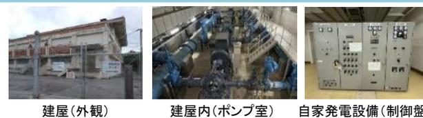
・令和5年の台風第6号襲来時の電力会社の停電時(43時間)に、更新が遅れているポンプ場の**自家発電設備の故障**により、**宜野湾市及び中城村の一部で断水(11時間)**
