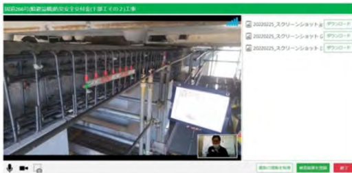
【立会状況（現場側）】
