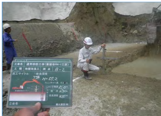
【出来形管理（杭ナビ測量）】
