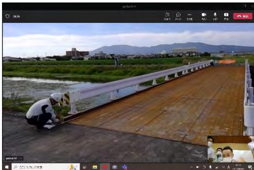
【立会状況(現場側)】
