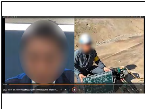
【立会状況（監督側）】
