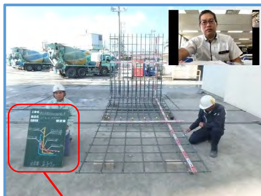
【配筋 立会状況（工場側）】
