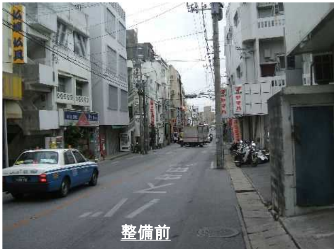
写真① 開南交差点付近
