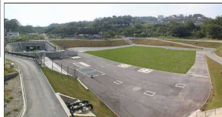
安慶田雨水調整池全景
