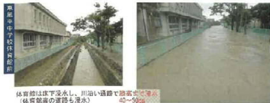
報得川上流 東風平中学校・国道507号ヘンサ橋の浸水状況(平成23年11月9日)
