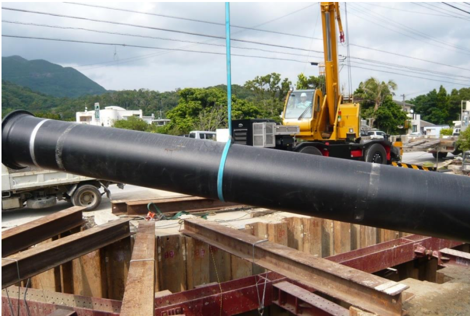
ダクタイル鋳鉄管吊り上げ状況
