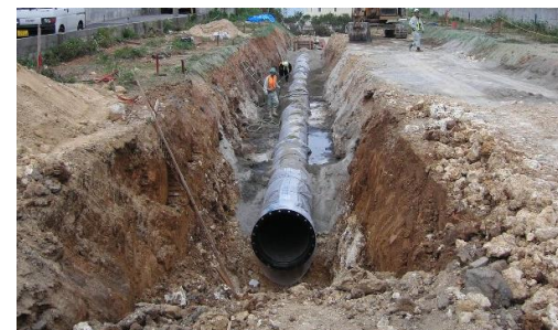
埋設管 (開削工法) 直径0.9メートル
