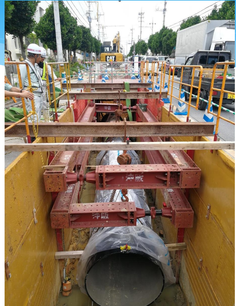
配管施工状況
