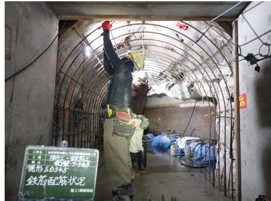
鉄筋配筋状況
