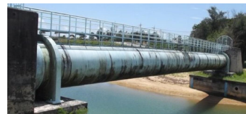
水管橋 (河川横断) 直径2メートル
