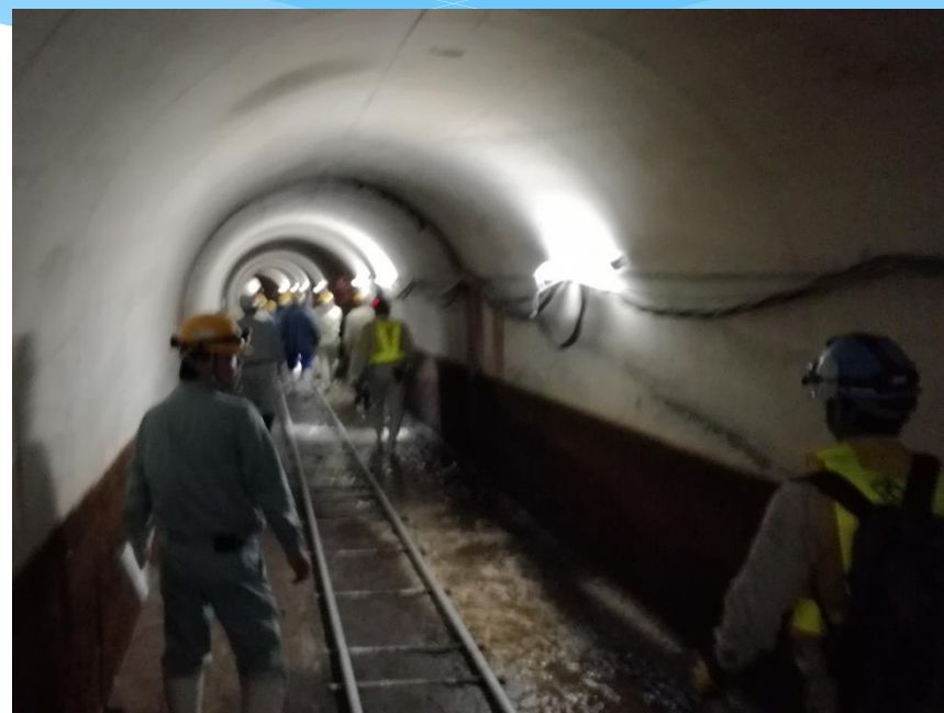
トンネルの補修・補強工事
