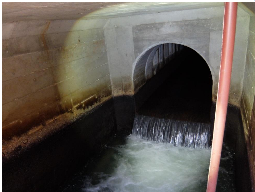
導水トンネル（建設後約50年）
