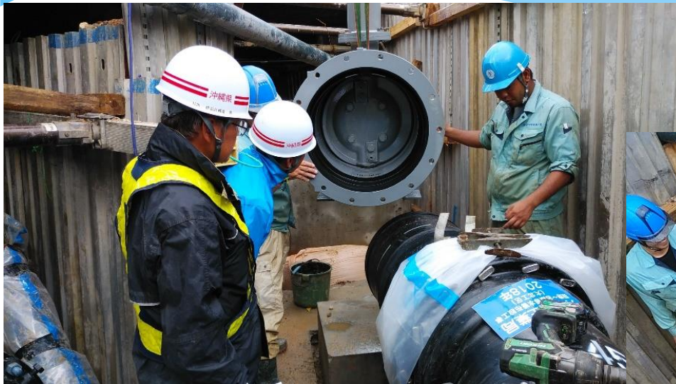
バルブ設置施工状況
