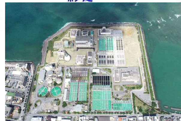
宜野湾浄化センター
