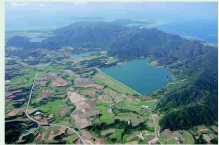
底原ダム・真栄里ダム・名蔵ダムの状況
