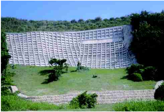
地すべり対策事業（法面保護）
