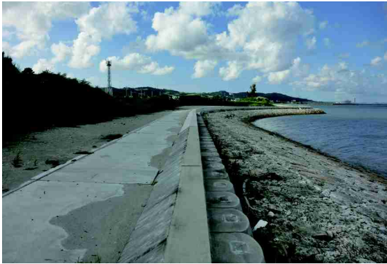
海岸保全整備事業（護岸整備）
