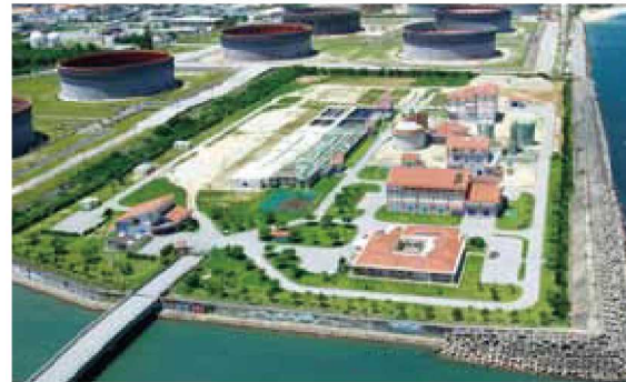
西原浄化センター(みずクリン西原)
