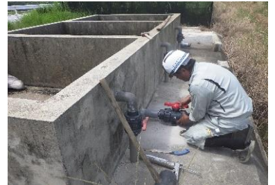
パイプライン補修
