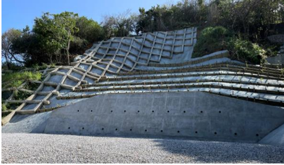
法枠工、筋工、山腹緑化工等(国頭村伊地)
