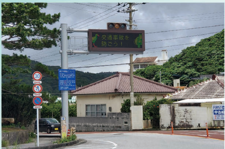
◀道路情報板の設置 (名護市源河)
