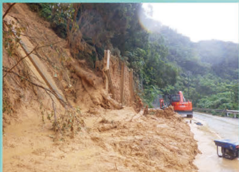
●2021.06豪雨により発生した土砂崩れ(東村有銘)
