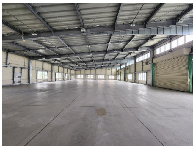
内部② (1 階作業場)
