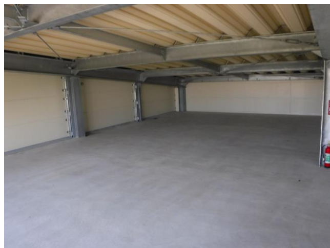
内部③ (2 階倉庫)
