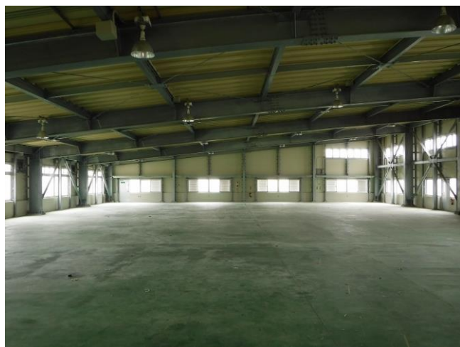
内部② (1 階作業場)
