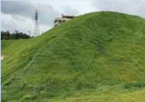
はっせいげんたいさくそうち しゅしゅ 発生源対策装置(種子吹きつけ)
