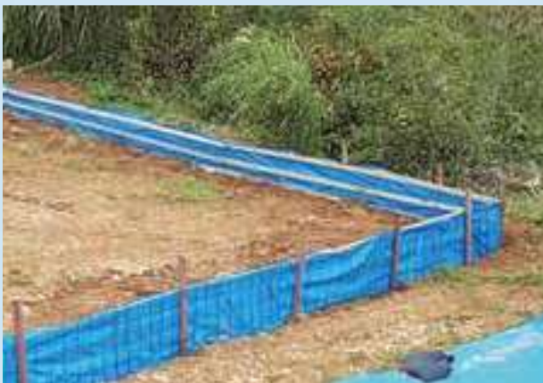
りゅうしゅつどくすいたいさくそうち さくこう 流出濁水対策装置(柵工)
