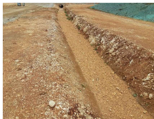
写真 切回水路
