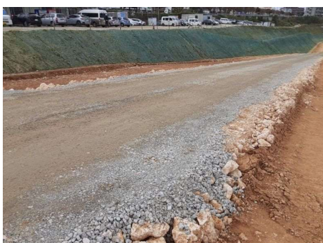
写真 砂利敷設
