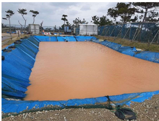
写真 自然沈殿池
