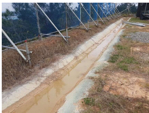
写真 場内仮設排水路
