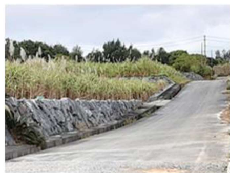
勾配修正されたほ場
