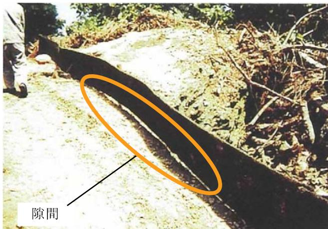
柵材下端部に地表面との隙間があり、濁水が漏れ出すため、濁水発生の抑制効果が低下する。
