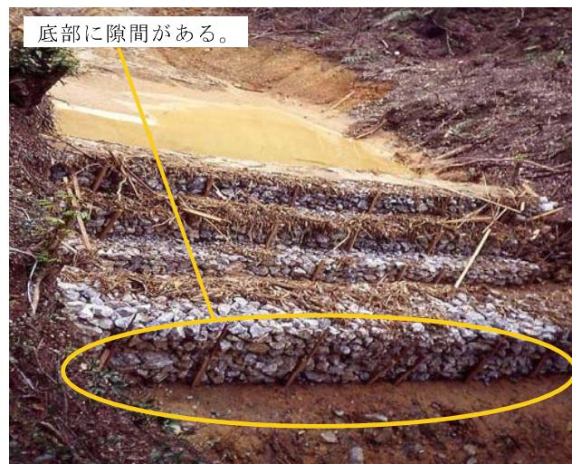
底部等が洗掘され隙間ができると、濁水が漏れ出し、濁水発生の抑制効果が低下する。
