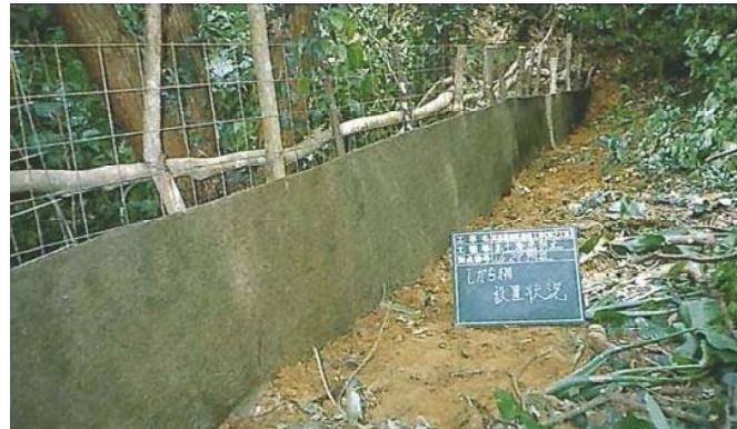
強い流水でステラシートが剥がれて濁水発生の抑制効果を妨げないようにするために、木杭とワイヤーメッシュにステラシートを固定している。
