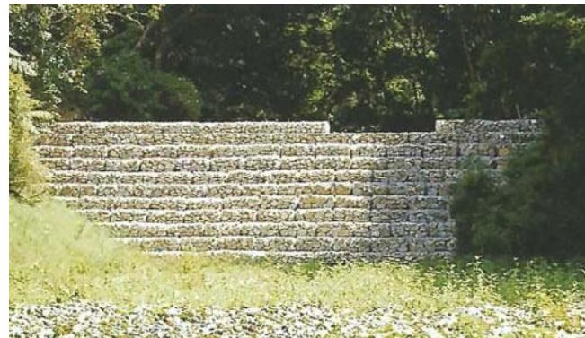
フトン籠の前面にステラシートを被覆することにより濁水のろ過機能により、濁水発生の抑制効果が高まる。
