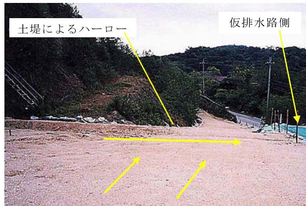
傾斜した道路面に斜めの土堤（土の盛上がり）を設置して濁水を仮排水路側へ誘導することにより濁水発生の抑制効果が期待できる。
