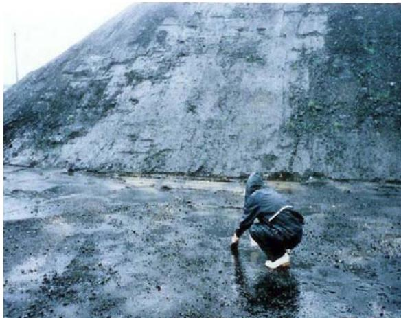
切土法面・車道の裸地の全面に、アスファルト乳剤を一様に散布している。はげ落ちや浸食痕はなく、濁水発生の抑制効果が期待できる。
