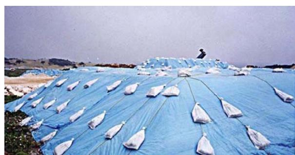
シートの巻き上げが起こり、裸地面が露出して雨が降り濁水発生が起こるので、干し柿式の土のうを配置しシートを押さえている。
