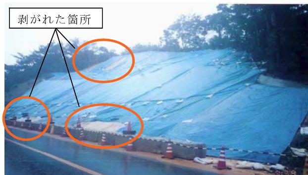
シートが一部剥がれたため、法面に降った雨がシート内に潜り法尻から濁水が流出し、濁水発生の抑制効果が小さくなる。
