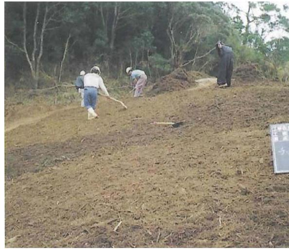
裸地面を一様に覆っている。マルチ材の敷設厚さを十分にとれば濁水発生の抑制効果が期待できる。
