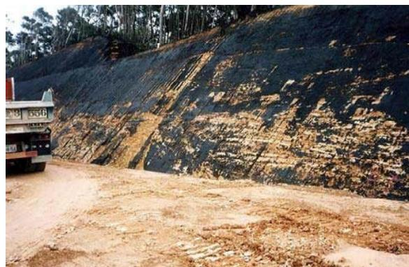
アスファルト乳剤を一様に散布しないと濁水発生の抑制効果が期待できない。車道も散布していないと濁水が発生する。また、散布から時間が経つと劣化し濁水発生の抑制効果が低下する。
