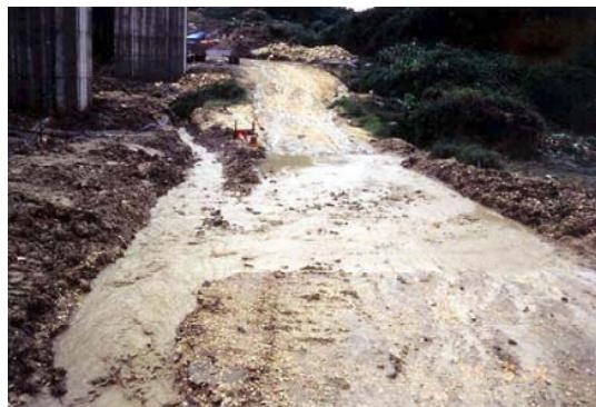
流しコーラルを敷設した場合、大型トラック等の重量車両の通過する車道では使用しない。(大型トラック等の重量車両の通行により、弛んだ地盤に、流しコーラルがめり込み土壌が浮き出して濁水が発生する。)
