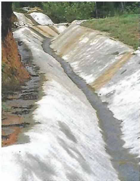
モルタル吹付けることにより、排水路側壁の洗掘を防止している。排水路の機能を維持するためには排水路側壁モルタルのひび割れ、はげ落ち及び排水路内の堆積土砂などに留意する。
