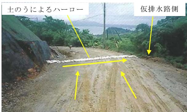
車両の通過によりハーローが崩れやすい。崩れた箇所から濁水が漏れだして濁水発生の抑制効果が低下することから崩壊箇所の確認に努める。
