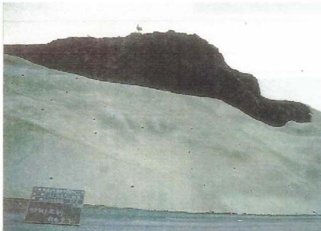
裸地の法面勾配が急であるため、モルタル吹付により対応した。法面にひび割れ、はげ落ちがみられると、降った雨により濁水が発生し濁水発生の抑制効果が低下する。
