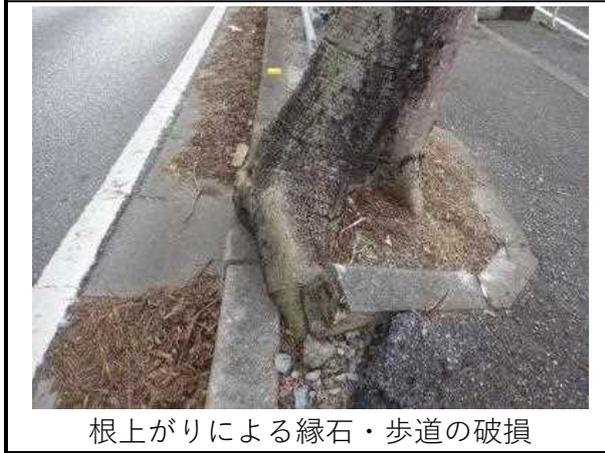
根上がりによる縁石・歩道の破損
