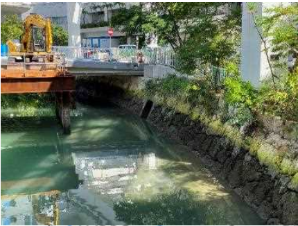
④⑦久茂地川公共雨水管出口付近 (甲辰橋)
