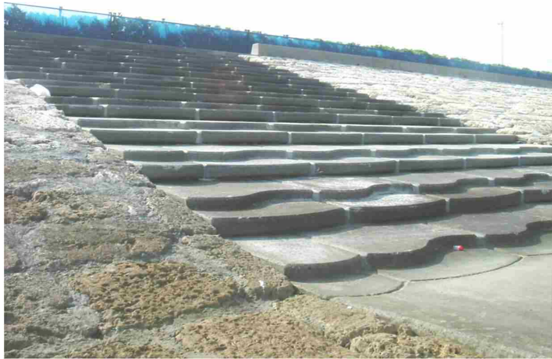
階段護岸（全景）
