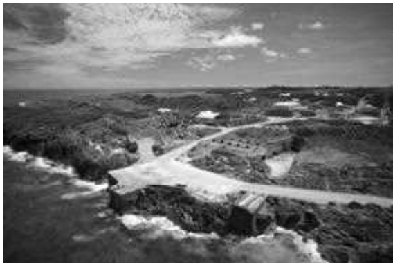
燐鉱石貯蔵庫 遠景
