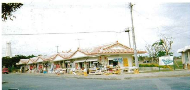
名称：平和祈念公園売店 新築工事 所在地：糸満市 工期：H7.2.23～H7.6.10 構造：RC造地上1階 延面積：220㎡ 総工事費：77,768千円
