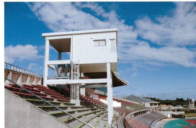
名称：沖縄総合運動公園陸上 競技場写真判定室増築工事 所在地：沖縄市 工期：H7.9.21～H8.2.17 構造：S造地上4階 延面積：41㎡ 総工事費：57,165千円
