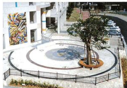
名称：県営兼原高層住宅建設工事 所在地：具志川市 工期：H6.3.25～H7.11.10 構造：RC・SRC造地上10階 延面積：15,261㎡ 総工事費：3,235,704千円
