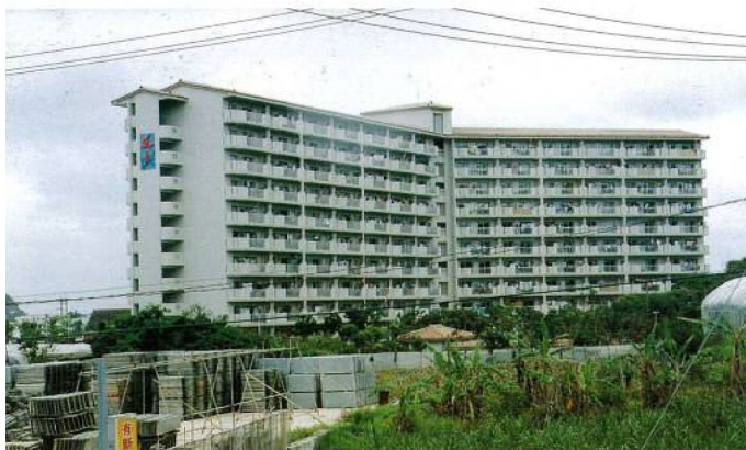
名称：県営翁長高層住宅 所在地：豊見城村 工期：H6.1.11～H7.8.2 構造：RC造地上10階 延面積：10,817㎡ 総工事費：2,474,502千円
