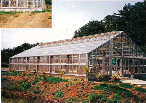
名称：農業試験場名護支場ハイブリッドライス育成温室 所在地／名護市 工期／平成1年8月22日～平成1年12月19日 構造／鉄骨造(平屋建) 延面積／180㎡ 設計／南ヨシ企画設計 総工事費／19,295千円 施工／建築：岡大三組 設備：金城電器
