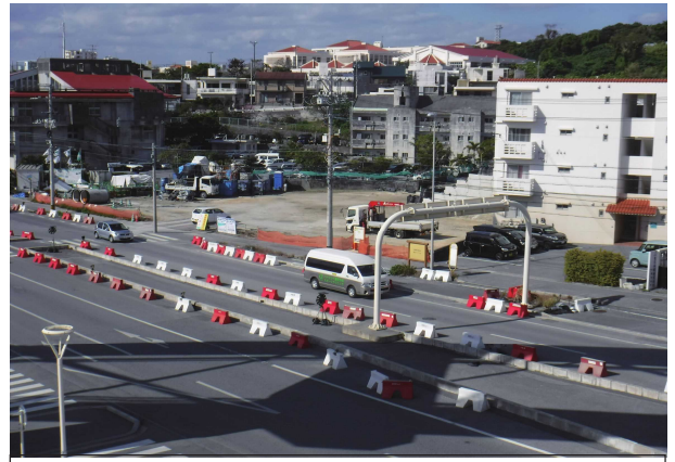
②県道38号線側
