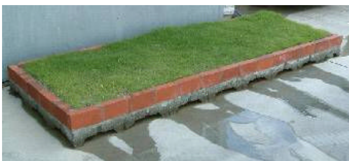
降雨後の透水状況
