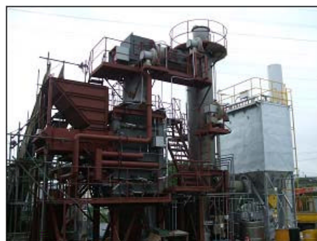
完成した中型焼却炉
