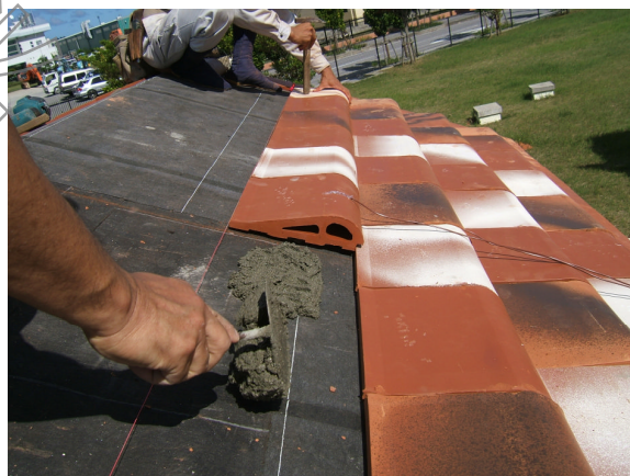
新しい瓦の施工
