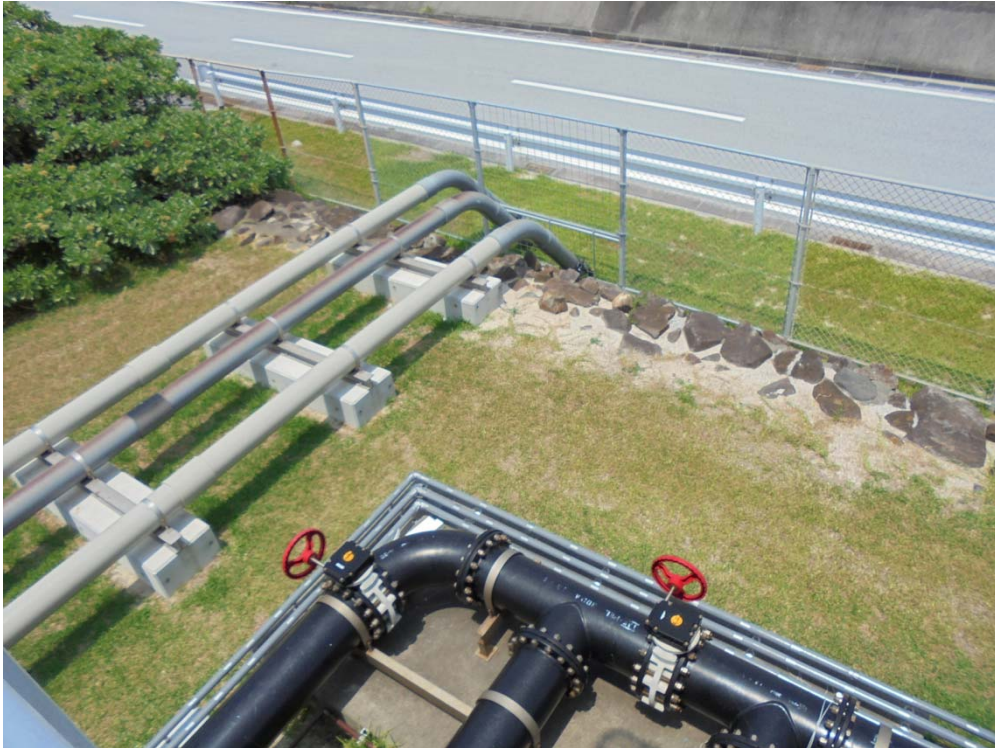
図 3-7 竣工時写真：発電後海水配管（研究所敷地境界フェンス部）
