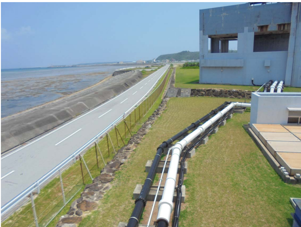
図 3-8 竣工時写真：発電後海水配管埋設部（フェンス左側の芝生部に埋設）
