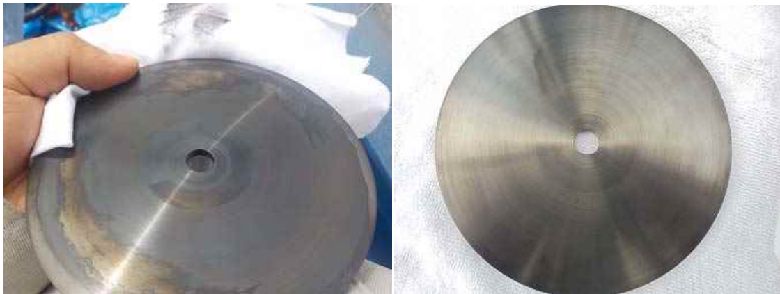
図 2-81 スラストカラー（発電機側）左：DSS 前、右：DSS 後 いずれも傷なし
