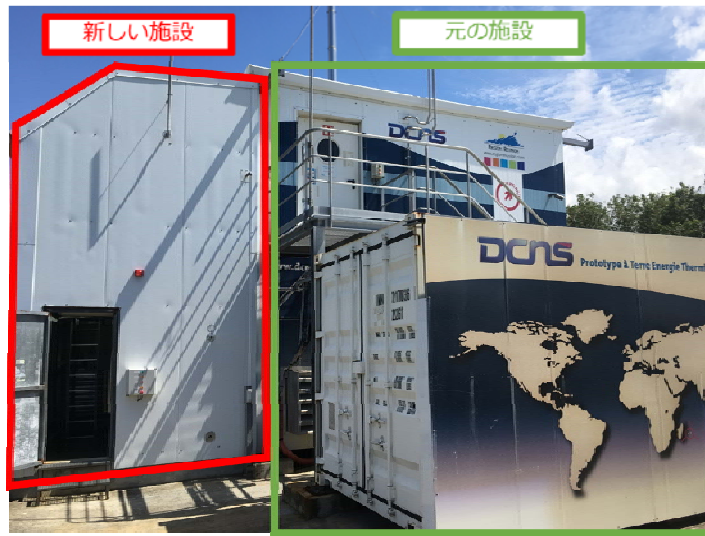
図 2-6(写真)NAVAL ENERGIES 社の OTEC 研究室(レユニオン島)
