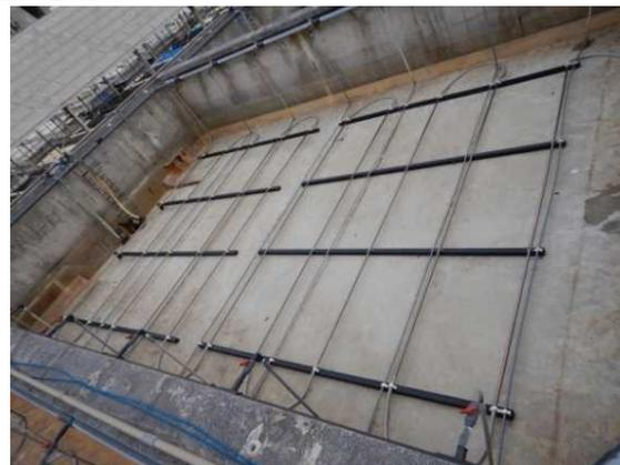
図2 ナンノクロロプシス培養水槽の熱交換システム
